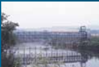
Grenzflusssperrwerk bei Göringen um 1985, heute das „Blaue Wunder“
