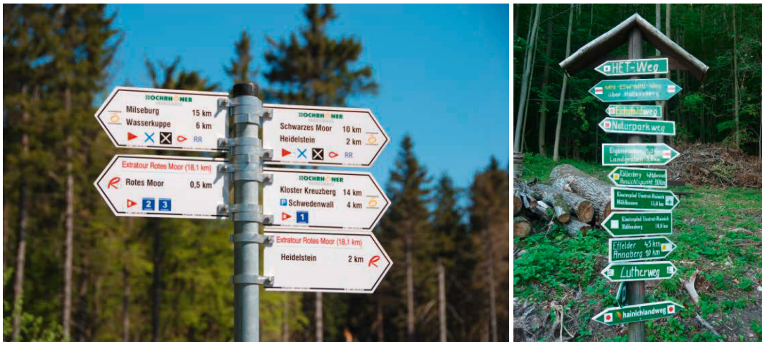
Abbildung 28: Vergleich von zeitgemäßer, platzsparender Befestigung an der Schilderwurzel (Beispiel Rhön) und mittiger Befestigung
