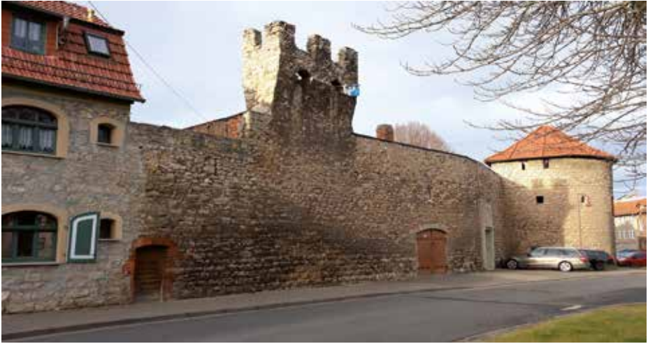
Blick auf ein Teilstück der alten Stadtmauer | Gelbe Route, Foto: © Karl-Heinz Wagner, Stadtilm
